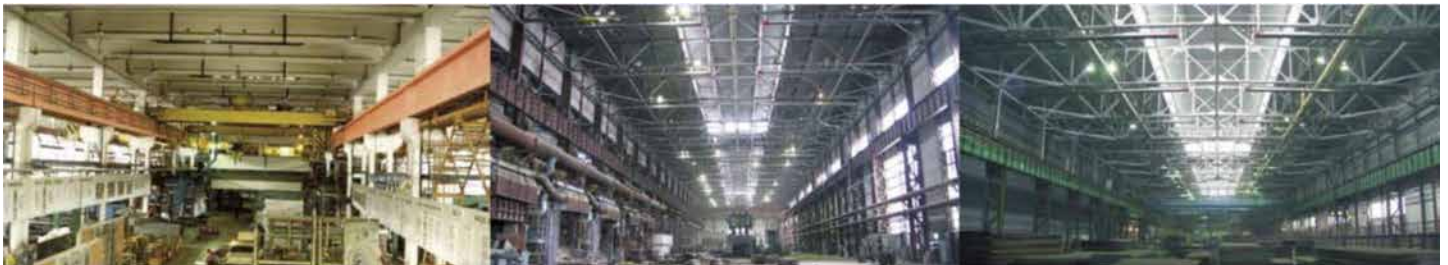
Краснопресненский з. ЖБК ДСК-1, г. Москва
