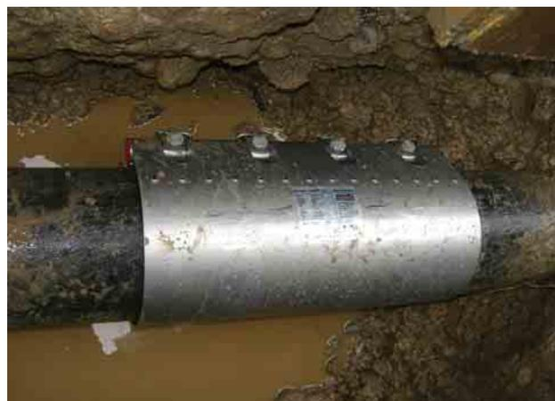
Ремонт повреждений размером до 250 мм
