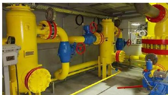
**Изготовление ГРП по СЯМИ.422411-630 ТУ производитель ООО ЭЗОТ "Сигнал" с учетом требований ТУ Газпром газораспределение ТУ 4859-020-73339504-2015.**
