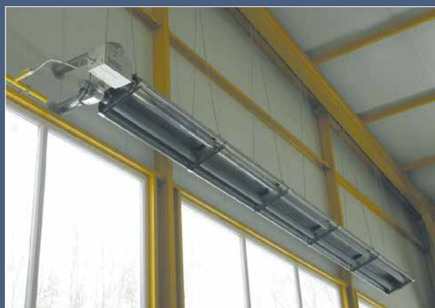
установка инфраизлучателя Helios
